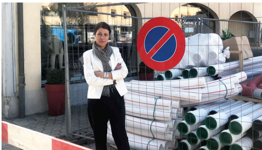
La commerçante Maria Rodrigues est très inquiète. Les travaux ont déjà fait chuter son chiffre d'affaires de près de 30%. DR
